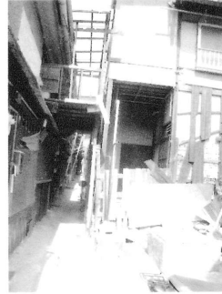
かなり傷んでいる建物を見た。時代を小路から感じる。
