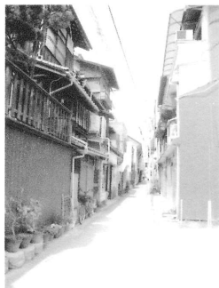
小川町の小路にある木造3階建ての家。
