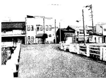
吾妻橋向こうに見える「備後今津郵便局」跡の建物。
