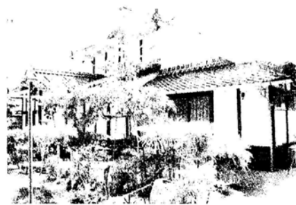
主屋を西側から見たところ。建物は明治後期のもの。
