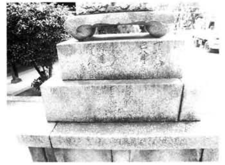
台座を見ると「安政四年巳八月吉日 願主 和泉屋保兵衛 當所石工 祐四郎」とある。
