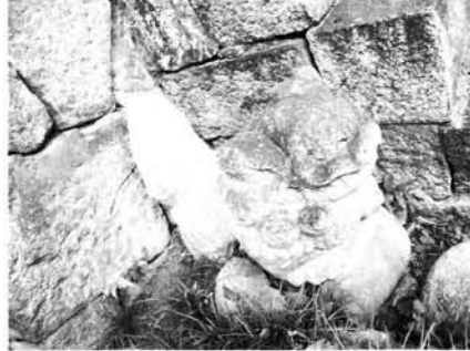
尾と胴体が割れている狛犬。小さくてかわいい狛犬だが、足の短さに注目してほしい。
