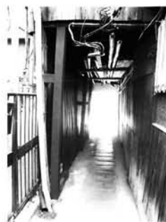
ここが建物の下を通る路地である。
