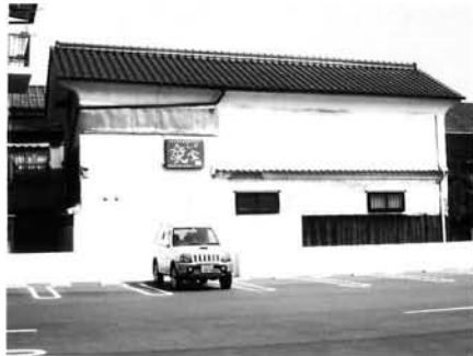
まだ残っている蔵の建物。本通りの裏 側にはこのような建物が残り、見るこ とができる。
