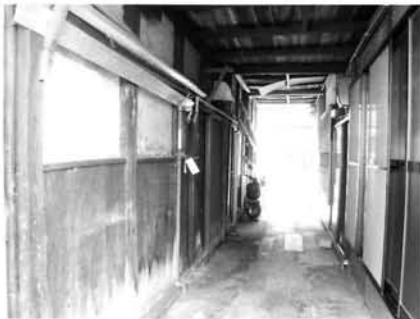
西側の路地は住宅の下をくぐる。左に折れるが行き止まりである。
