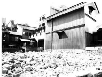
建物がなくなり様子が一変している。 蔵だけが残っている。
