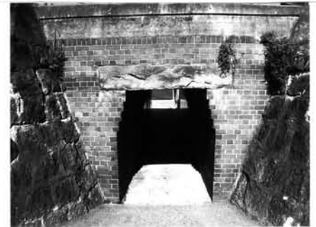
南の国道側から見た、正言小路に入って行くガード。山陽鉄道時代の歴史がレンガと花崗岩から感じることができる。
