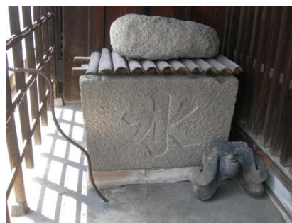
〈軒下の防火用水〉
