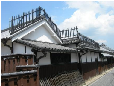
〈屋根上の忍び返しと道路際の犬矢来〉 〈道路際の駒よせと格子窓〉 〈軒下のもちおくり〉
