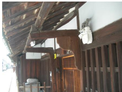
〈屋根上の忍び返しと道路際の犬矢来〉 〈道路際の駒よせと格子窓〉 〈軒下のもちおくり〉
