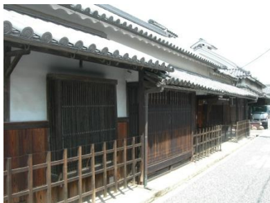
〈屋根上の忍び返しと道路際の犬矢来〉 〈道路際の駒よせと格子窓〉 〈軒下のもちおくり〉
