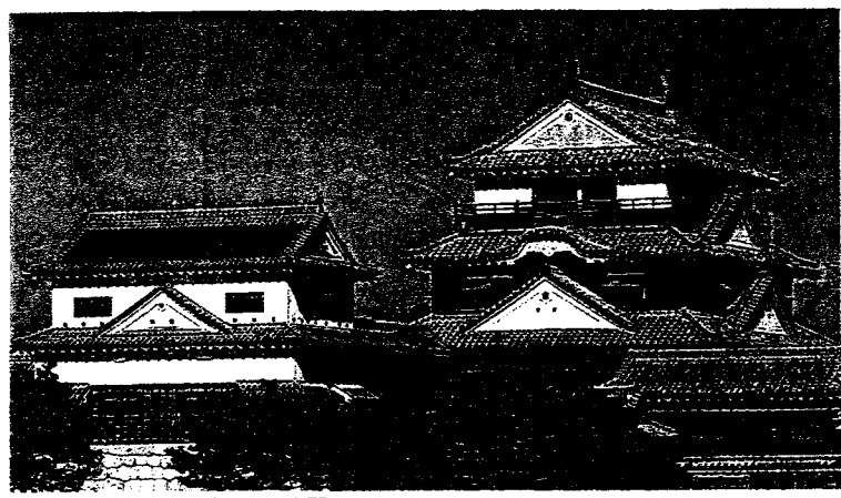
▲天守閣(重要文化財)と小天守閣 天守閣は三重三層地下一階付の建築で、日本の天守閣で最も後期に再建されたものである。この建築の技工は使用されている材料とも超一流の建造物である。 小天守閣は、大手(追手)方面を防衛し、からめ手方面を側防し、二ノ丸・三ノ丸方面を監視することのできる位置にあり、城内の諸櫓の中で天守閣について重要な櫓であるのでこの名がある。小天守閣の大棟には両端に瓦の鯉が覆かれ、城郭建築の威厳を示している。
