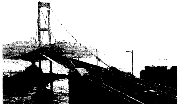
《安芸灘大橋（川尻町から下蒲刈島を望む）》
