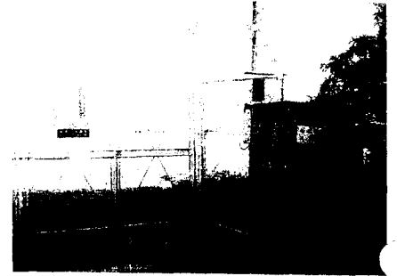
浄水場跡は整地され、厳重な柵によって中に入れない。2年前には入れたのに残念である。
