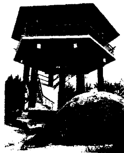
新しく建設された展望台。高いので周囲の景色がよくわかる。
