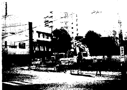
南に下る道。橋本別邸の庭は重機の ところまでであった。
